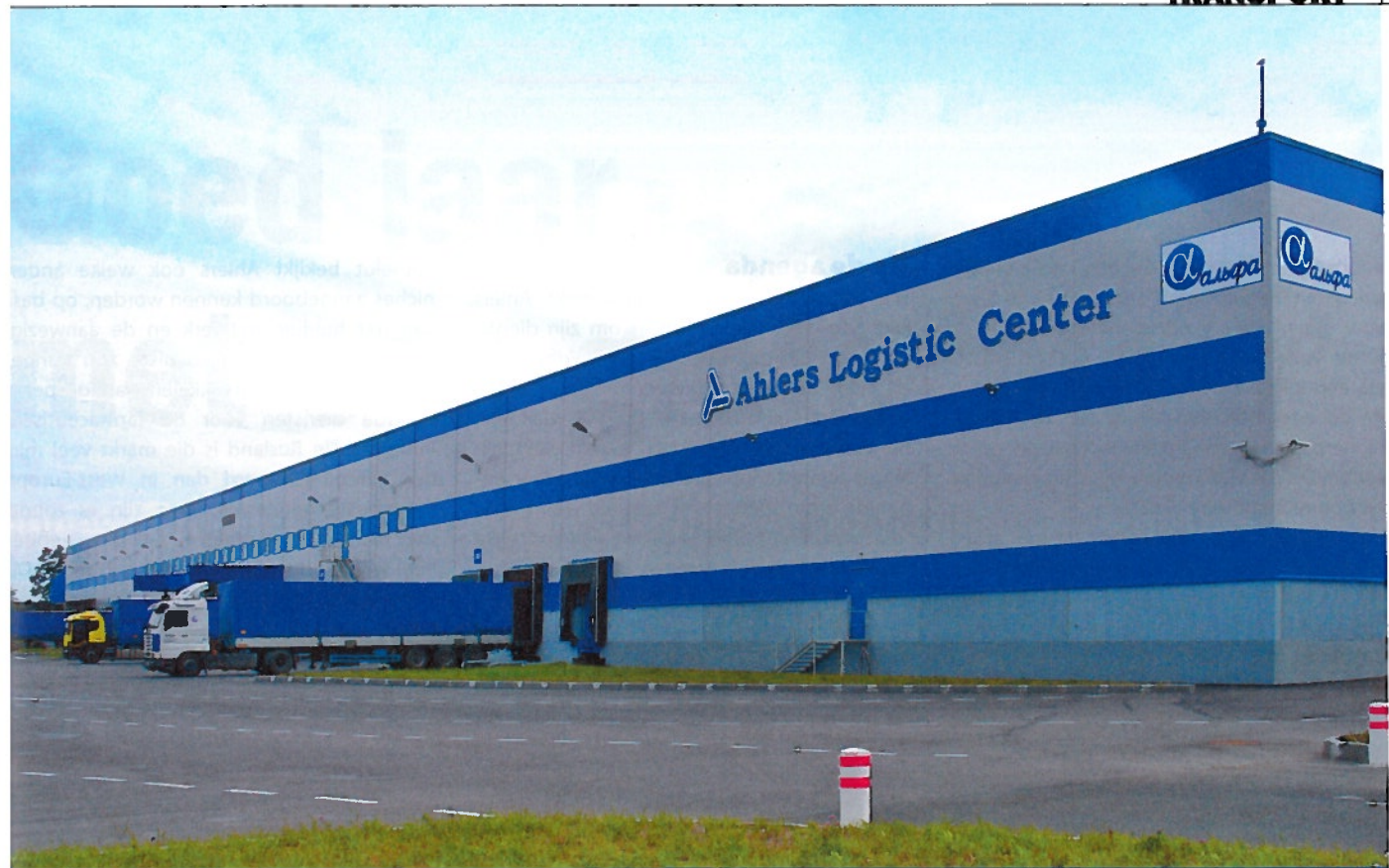
Ahlers beschikt vandaag in het GOS over zes eigen magazijnen (vier in Sint-Petersburg en twee in Oekraïne) en heeft bijkomend ook operaties in vier externe magazijnen.
