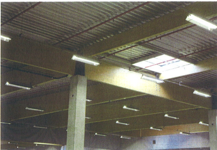
Het dak rust op houten spanten. Die stellen de brandweer beter dan stalen spanten in staat om bij brand een inschatting te maken van het instortingsgevaar
